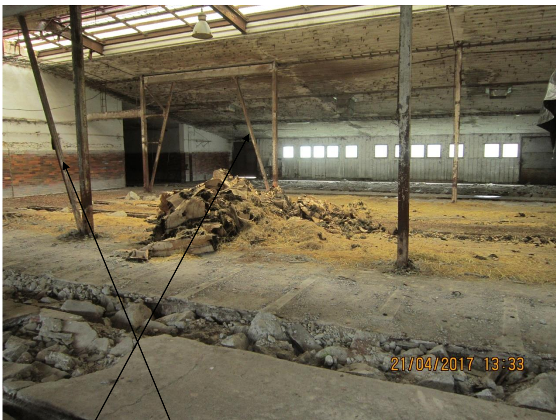
svislé zavětrování mezi sloupy nahradit rámovou konstrukcí
