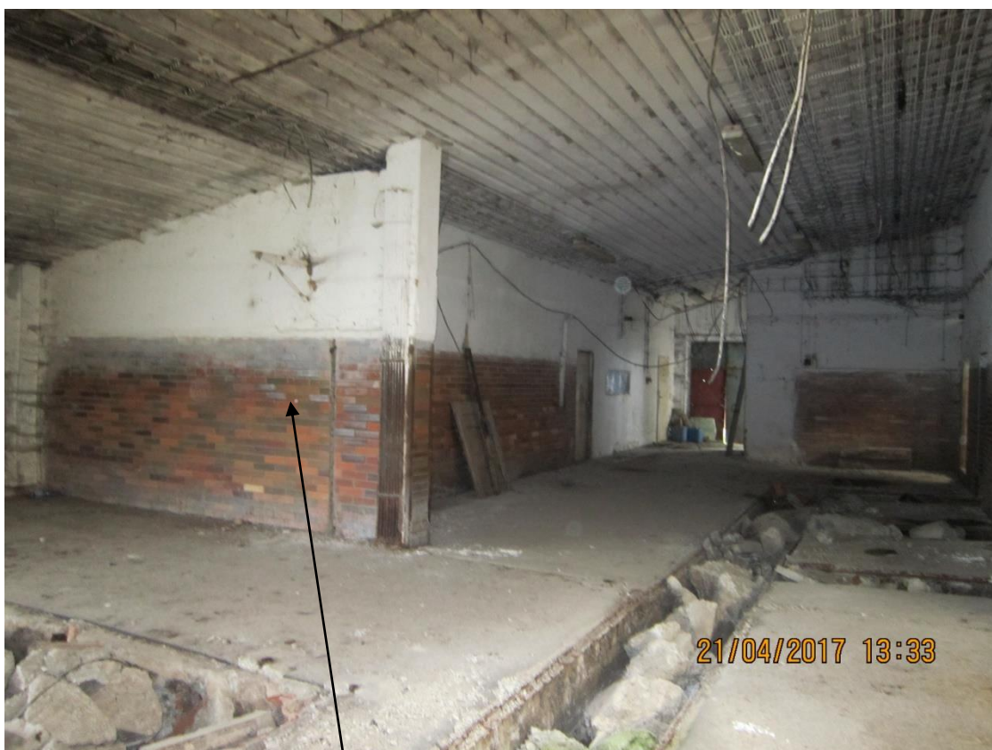
vnitřní zděné konstrukce vybourat až k podlaze
