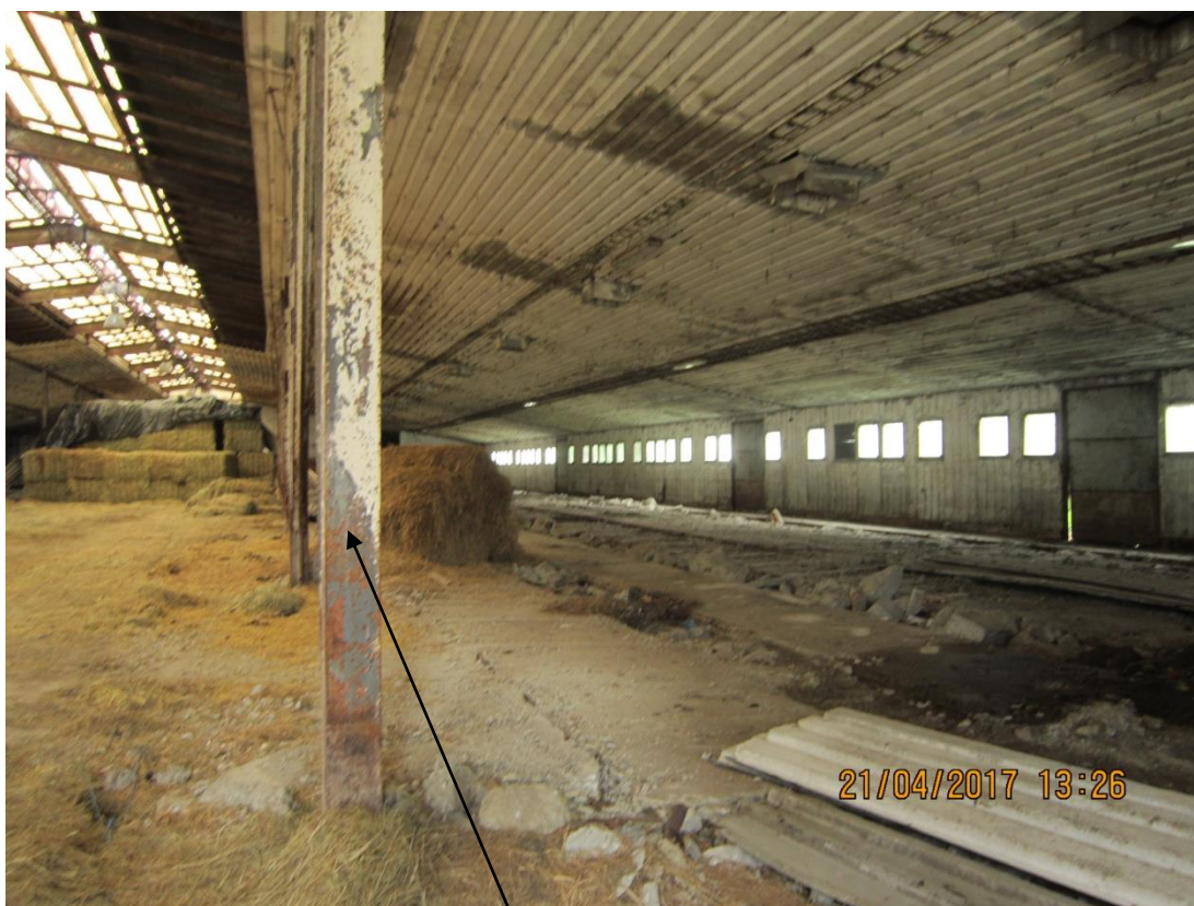
vnitřní sloupy vyrovnat, zesílit zabetonováním a opatřit povrchovou úpravou
