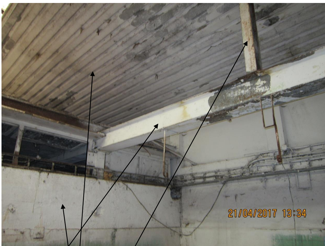
vnitřní zdivo vybourat kompletně podhled demontovat průvlak demontovat a doplnit sloupy s novými základy
